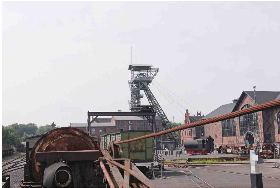
LWL-Industriemuseum am Standort Dortmund, Blick auf den Förder-turm von den Gleisanlagen aus Foto: © 2018 by Schattenblick
