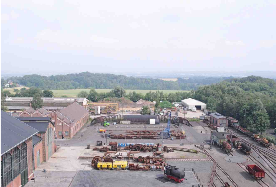
Infrastruktur der Kohleförderung Foto: © 2018 by Schattenblick
